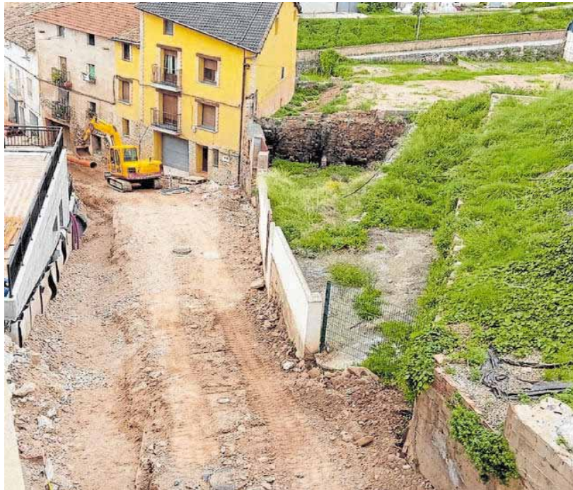
Vista de la calle Barranco, actualmente en obras para renovar la red de abastecimiento. AYTO. DE RIBAFRECHA
