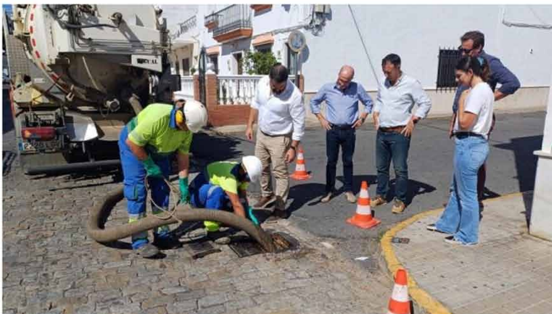
Limpieza del alcantarillado en Cartaya
